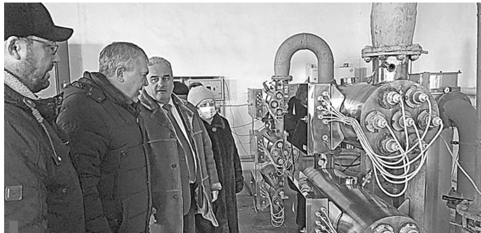
Вода перед подачей потребителю обеззараживается ультрафиолетом
